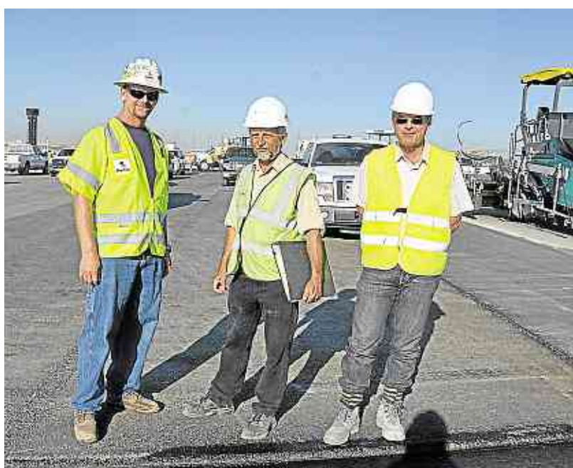
Die Spezialisten aus Neuwied Dr. Rainer Hart (Mitte) und Geologe Jürgen Mika (rechts) auf der Baustelle in Austin im Gespräch mit Brian Arent, Oberbauleiter der Bauunternehmung Austin Bridge & Road. Die Neuwieder haben seit 1998 mit zwei Ausnahmen den Bau aller neuen Formel-1-Rennstrecken begleitet.
