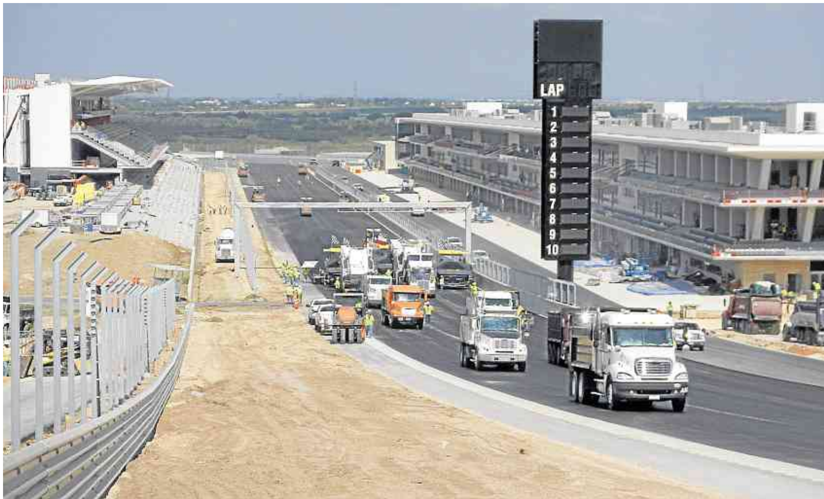
Grande Finale: Kürzlich wurden die letzten Meter an der Start-Ziel-Geraden in Austin eingebaut. Am Wochenende fährt hier die Formel 1.
